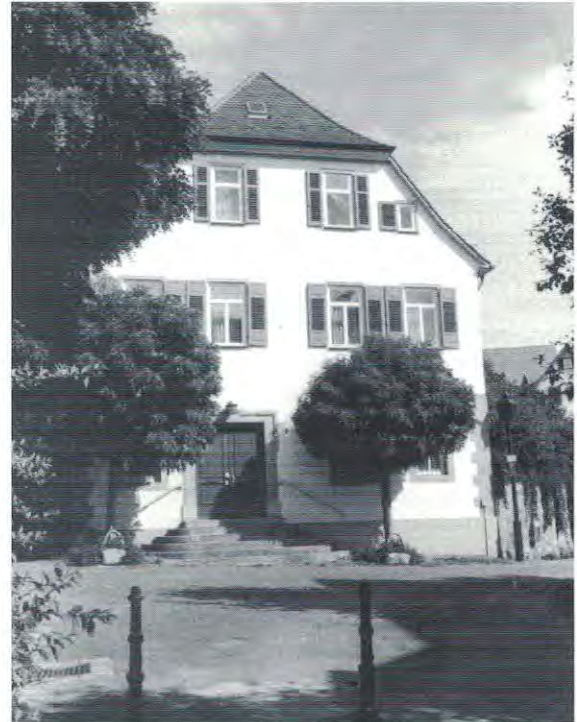
Bild 4: Pfarrhaus des Ev. Pfarramts Nord, Kirchplatz 5 (Foto: Petra Schad, 2002).
