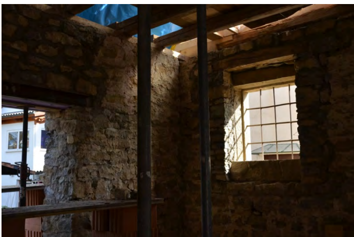
Abbildung 9: Sandsteingewände nach der Umsetzung von der West zur Ostwand von Innen und Außen.
