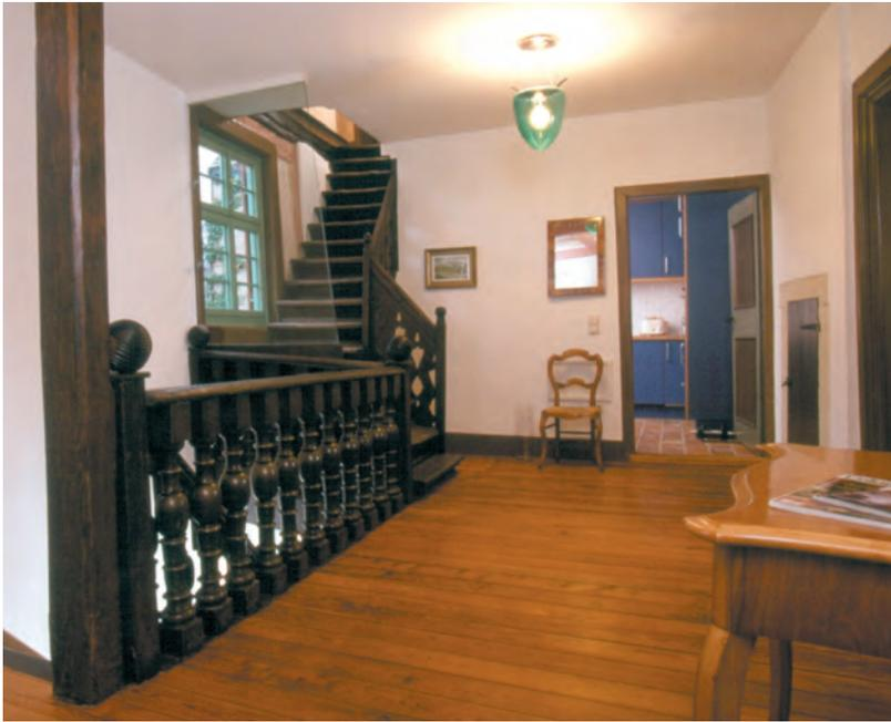
*Bild 14: Treppenhalle im 2. Obergeschoss, Keilblockstufentreppe zum Dachboden , im Hintergrund (Foto: Gerhard E. Schmid)*
