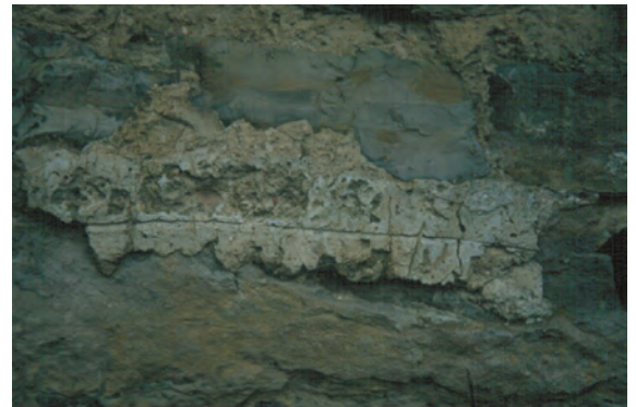
Bild 3: Kerbungen einer Scheinquadrierung (Foto: Martin Holzinger)
