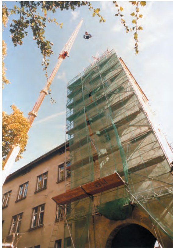
Bild 17: Mit einem Riesenkran wurde 1987 die neue Turmspitze hochgehievt (Foto: Stadtbauamt)
