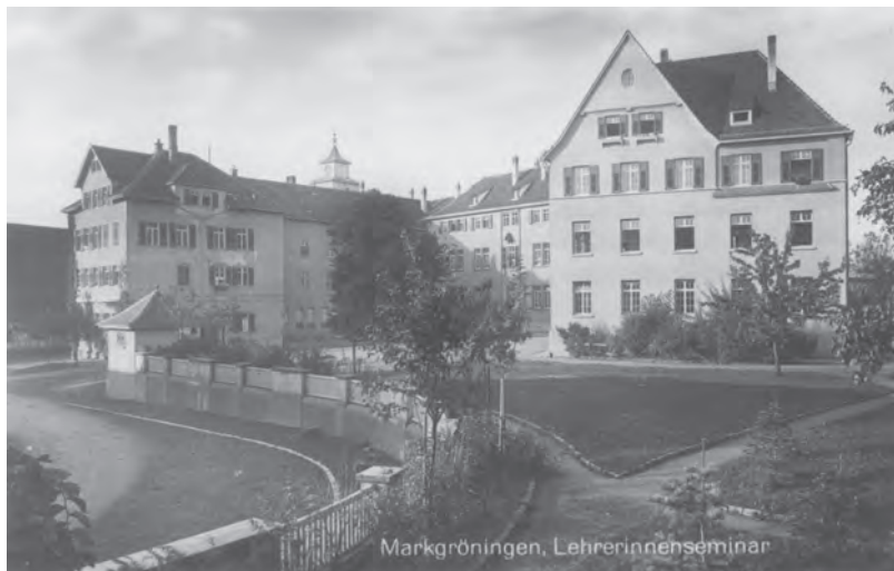
Bild 5: Das Lehrerinnenseminar 1930 nach dem Abriss des Krankenbaues, des Waschhauses (1908) und dem späteren Anbau des Nordflügels (Foto: StadtA M)
