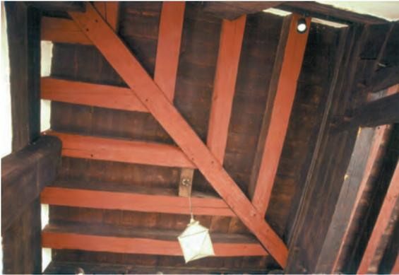
Bild 9: Stichgebälk in der Südostecke des Erdgeschosses (Foto: Helmut Hermann)
