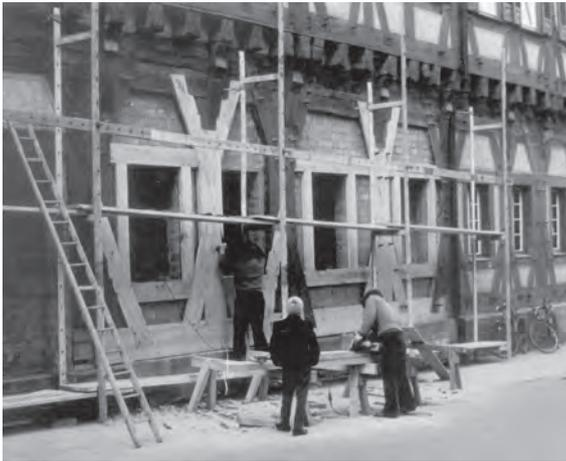
Bild 11: Anstelle der Tore des Feuerwehrmagazins wird Fachwerk eingebracht (Foto: G. Gläser-Schinz)
