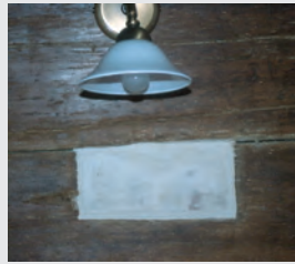
Bild 9: Verputzte Öffnung eines bauzeitlichen Fensters in der Nordwand im 1. OG von Marktplatz 2 (Vorlage: Stadtarchiv, Foto: Petra Schäd)
