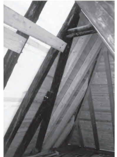
Bild 12: Dachstuhl mit ehemaligem Rauchloch (Vorlage: Stadtarchiv, Foto: Petra Schad) Der 1785 nach Westen verlängerte Dachstuhl ist am neuen Holz, das Rauchloch als Dreieck rechts oben im Bild erkennbar.
