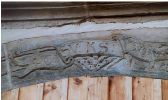
Bild 9: Wappen der Bauherren Sebastian Wimpelin (links) und Katherina Scheyhing (rechts) (Vorlage: Stadtarchiv, Foto: Petra Schad)
