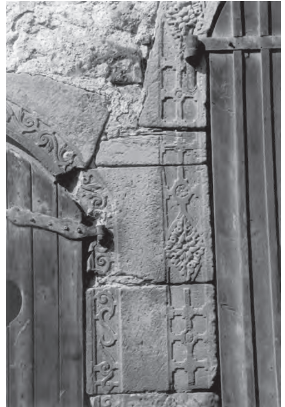
Bild 12: Das von beiden Seiten bearbeitete Steingewände zwischen Kellereingang und Scheuneneinfahrt im Jahr 1999 (Vorlage: Stadtarchiv, Foto: Petra Schad)
