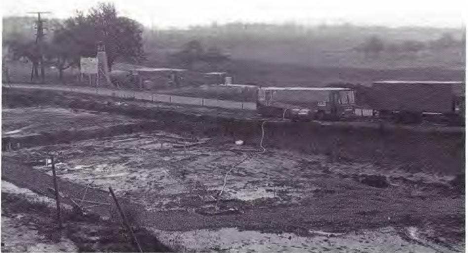
*Die Deponie Scherwiesen hat sich unter Fachleuten einen Ruf als Modell für mustergültige Entsorgungstechnik erworben. Seit Januar werden die chlorierten Kohlenwasserstoffe aus dem Boden gesaugt und in einer Filteranlage gebunden.*
