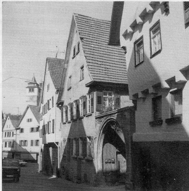
Straßenfassade Eßlinger Gasse 7
