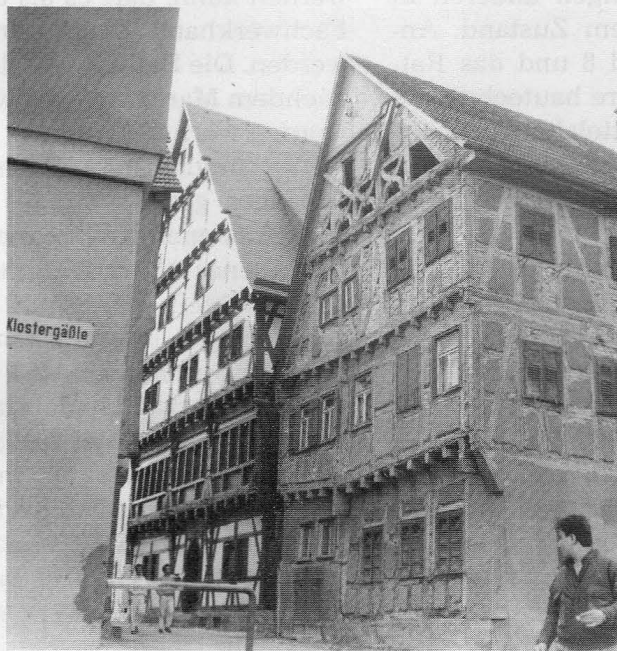
Finstere Gasse 4, ehemaliges „Pfeifer- sches Haus“.
