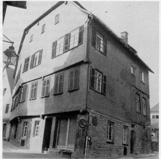
Haus Günzler von Südosten
