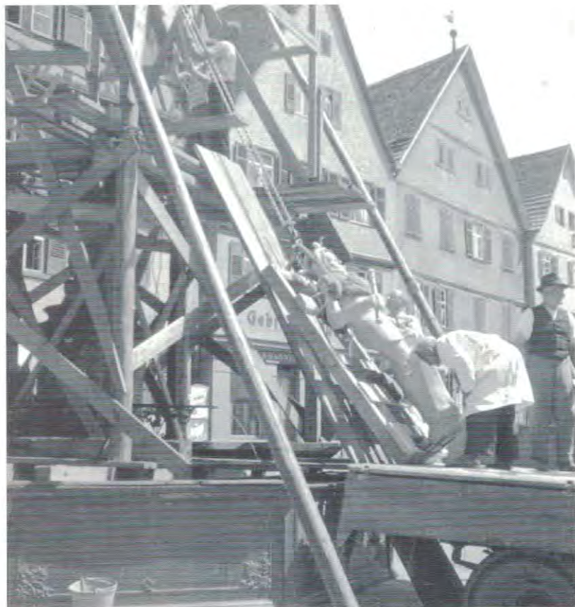
Bild 6: Der restaurierte „Marktbrunnenmann“ kommt wieder auf sein Podest (Foto: Elsbeth Sieb).
