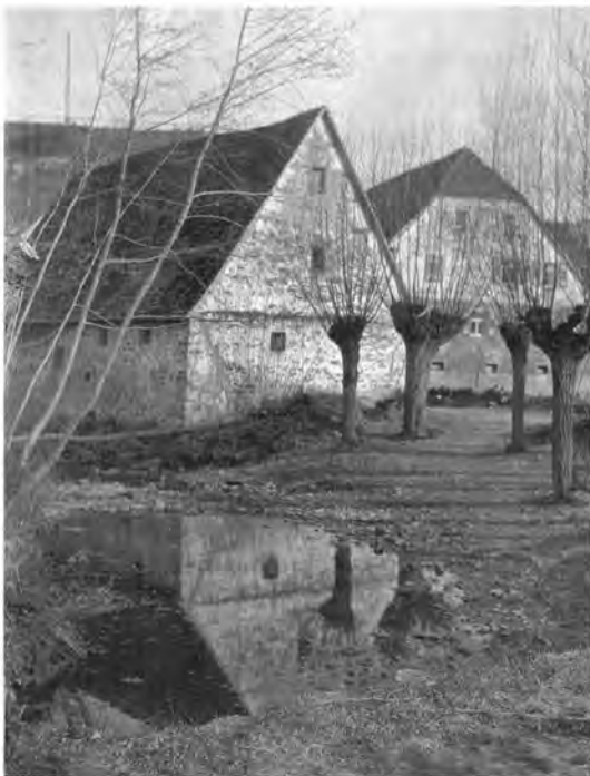
Die Obere Mühle – abgerissen
