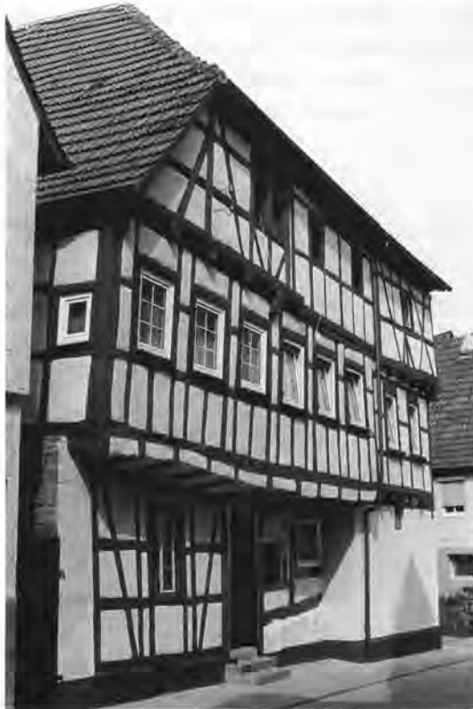
Das vermutlich älteste Bürgerhaus der Stadt, erbaut 1347 (AK GHD)
