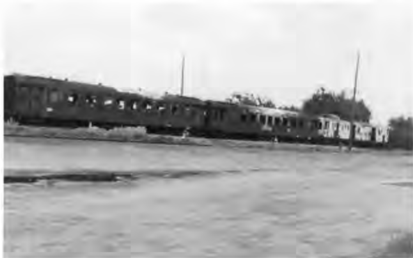
Das zerschossene Zügle auf dem Abstellgleis. (Wild)
