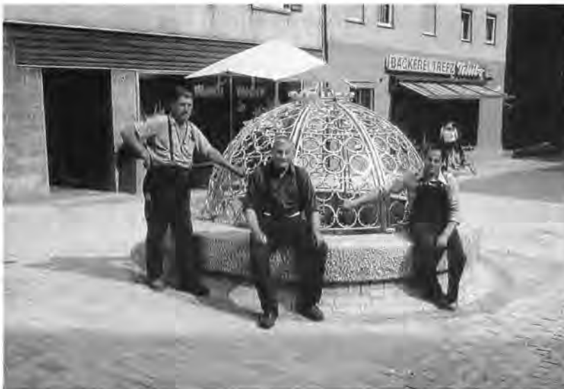
Als der Marktplatz gepflastert und autofrei gemacht wurde, erhielt Firma Gröner den Auftrag für die Kuppel über den ehemaligen Ziehbrunnen. Zu dritt schafften sie es. Links Stefan Knötig mit Bernhard und Erich Gröner (Gröner)
