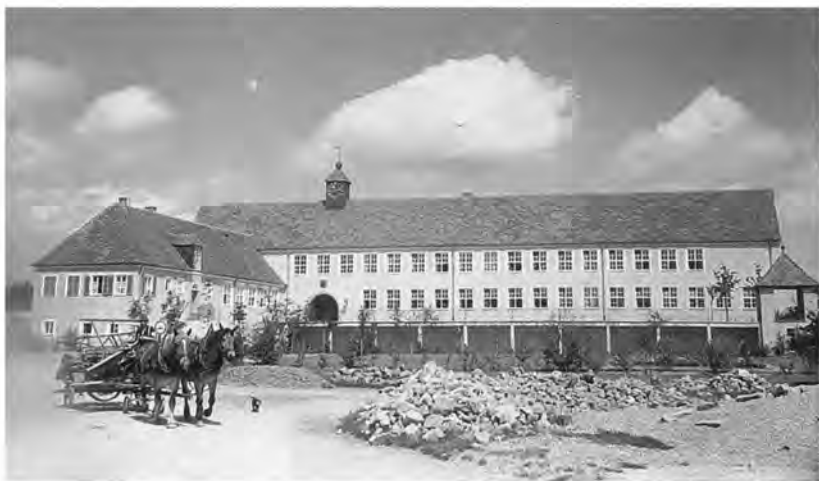
Die schmucke Ludwig-Heyd-Schule wurde in einer Zeit gebaut, als die Bauern noch mit zwei PS samt Hund unterwegs waren. (Haidle/AK GHD)
