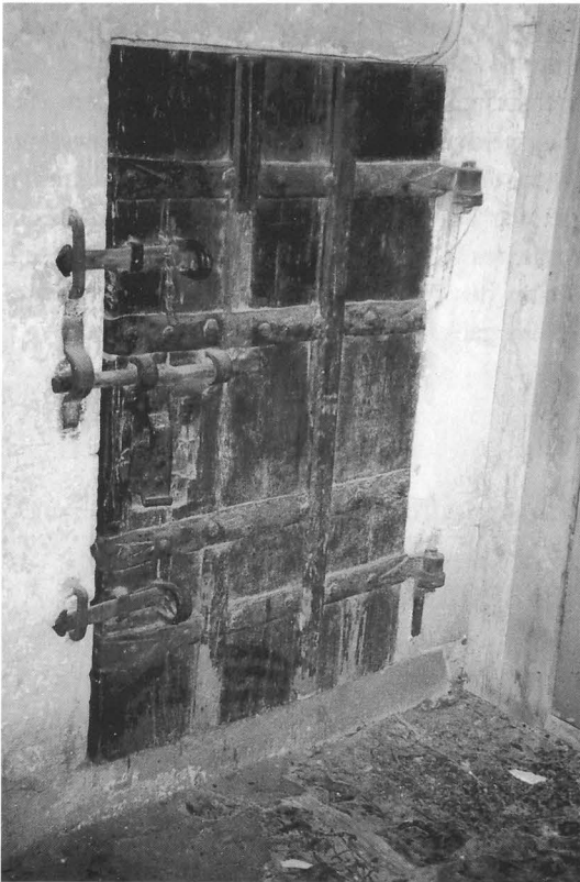
Die Türe des Gefängnisses ist dreifach gesichert (Fendrich)
