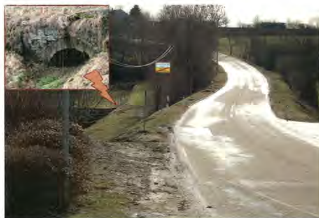
Ortsausfahrt und gewölbte Straßenbrücke
