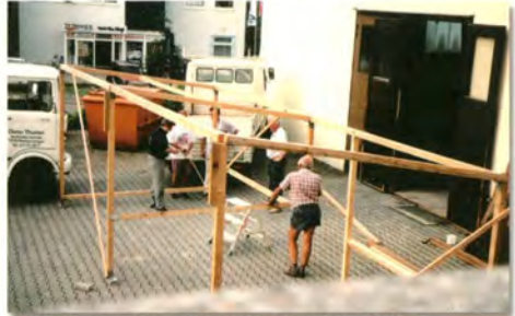
1996 Gerüstvorbereitung für den Schäferlauf
