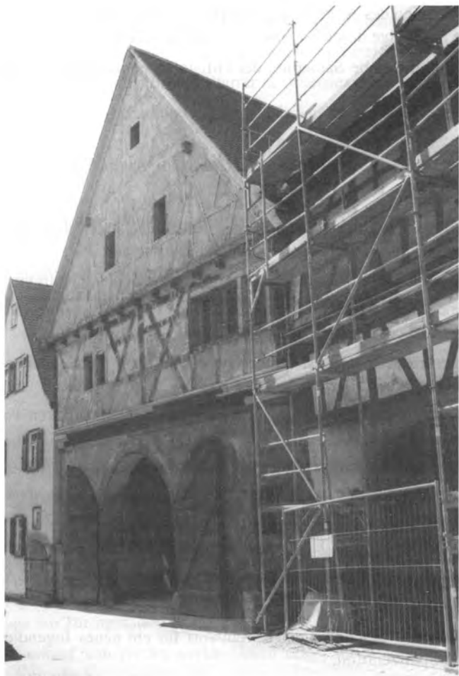
Vorschreitende Sanierung: Wimpelinhof
