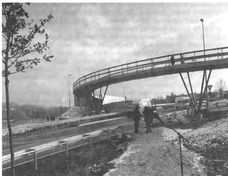
Die neue Brücke für Fußgänger, Rad- und Rollstuhlfahrer
