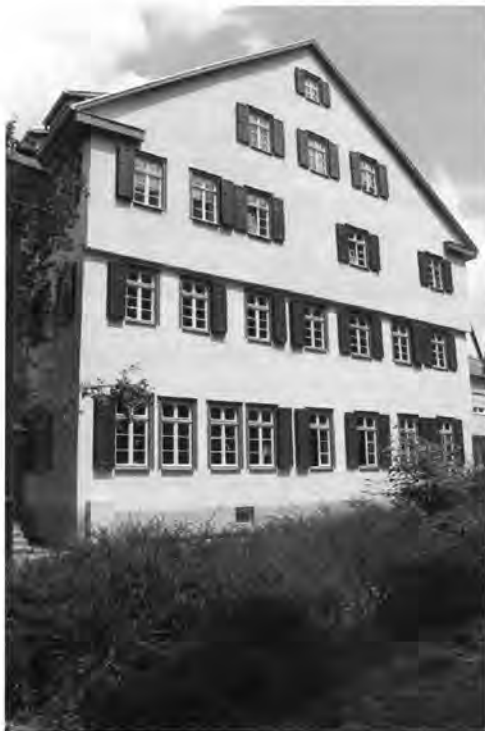
Vorbildliche Sanierung Kirchplatz 2
