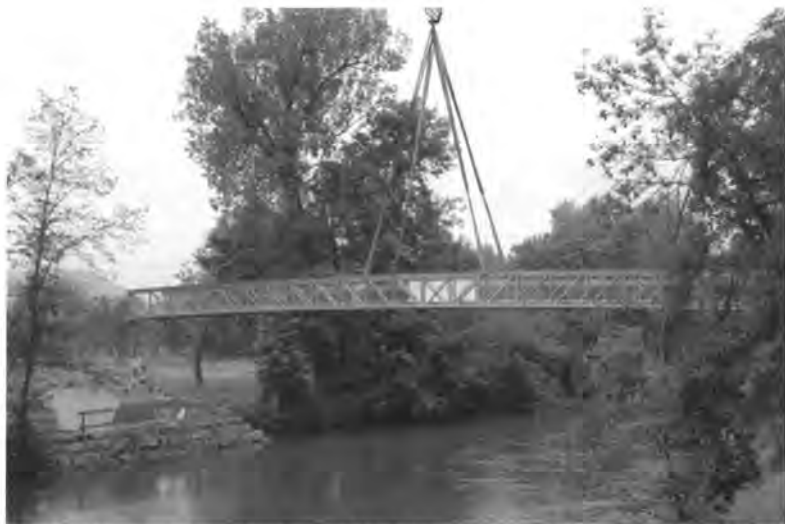
Die Radwegbrücke schwebt ins Widerlager
