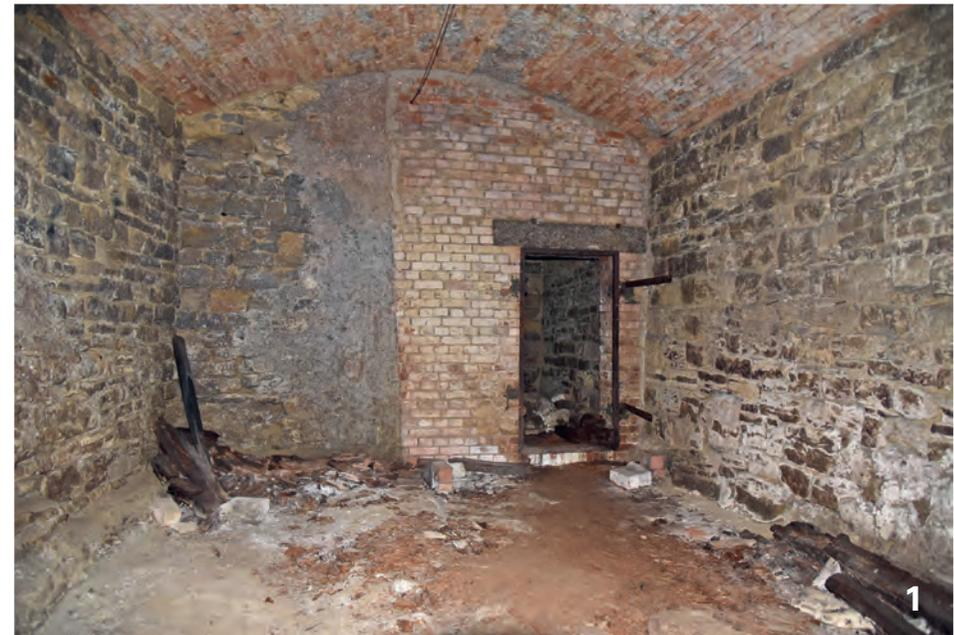
Die Ostwand von R5 ist zweigeteilt. Die Sockel der Seitenwände bestehen aus Fels.
