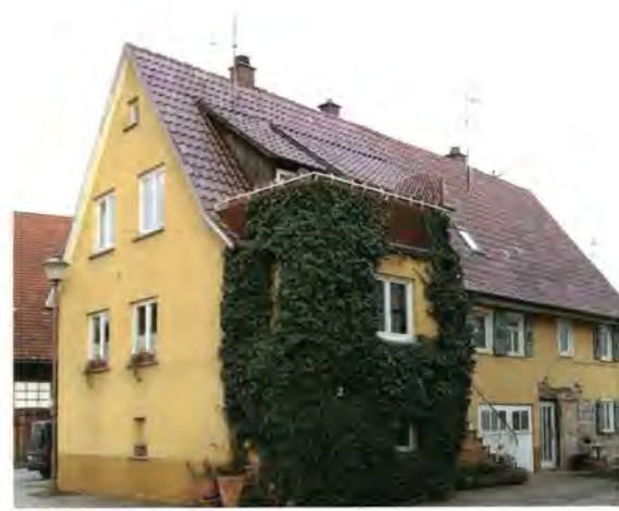
Das Haus im Schulweg 2, Baujahr 1770
