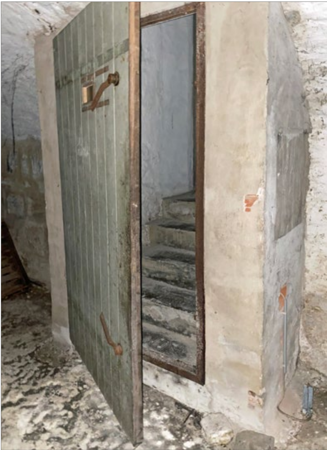
Zugang zum privaten Luftschutzraum im Keller von Haus Näher in der Bahnhofstraße
