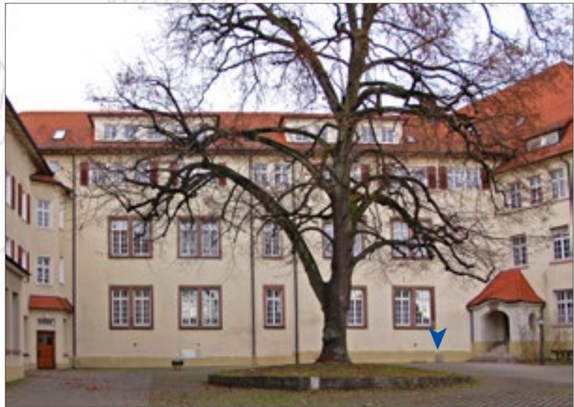
Mittelbau (Palas), dessen Keller in drei Luftschutzräume aufgeteilt wurde.
