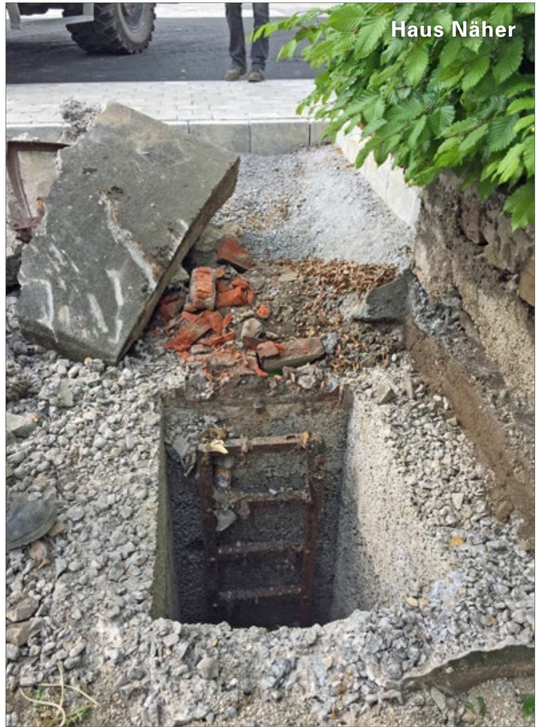
Notausstieg des Luftschutzraums von Haus Näher
