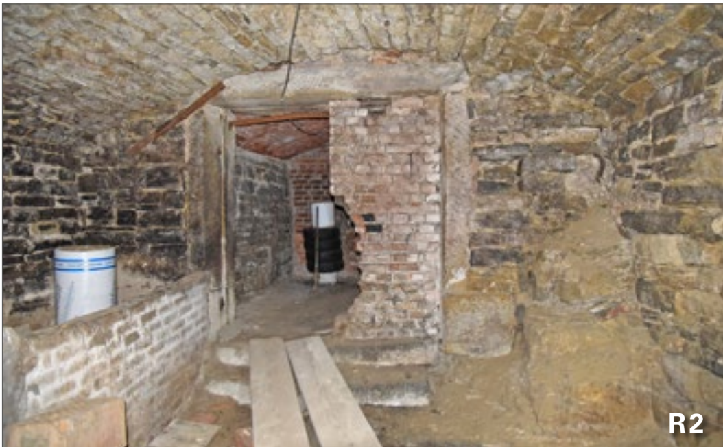
Das ursprünglich gleiche Bodenniveau von R2 liegt zwei Stufen tiefer als das von R1 (von Osten).
