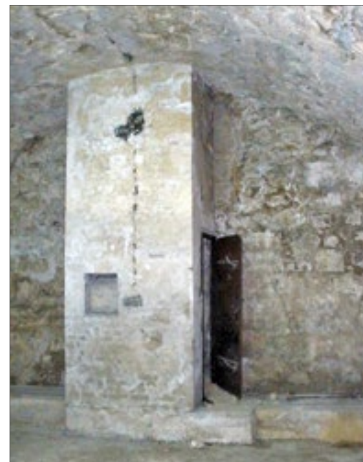
Treppenturm des Notausstiegs nach Westen
