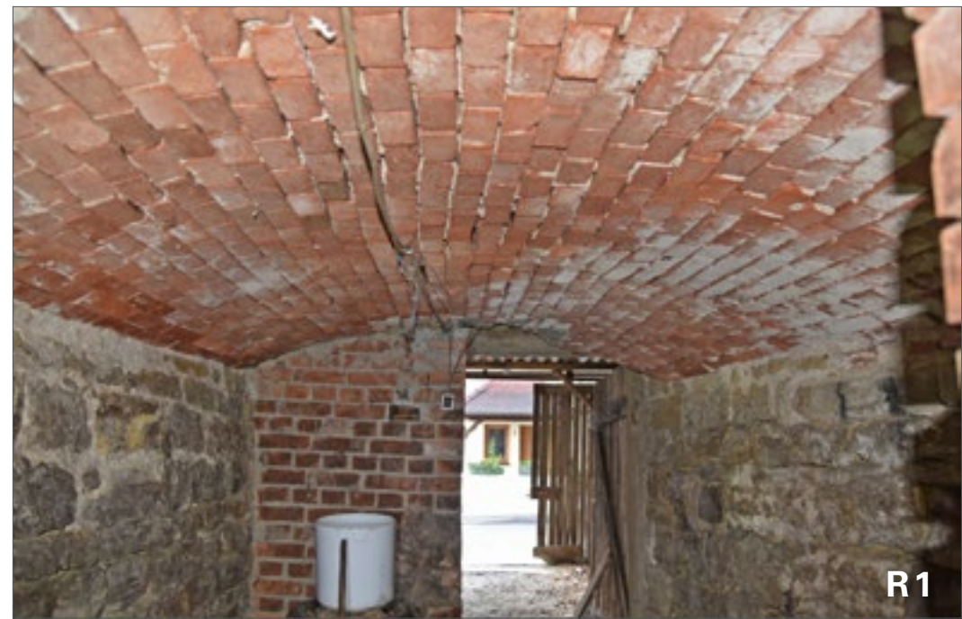
Raum 1 von Osten: mit neuem Gewölbe und halbiertem Zugang zur Gasschleuse umgebaut
