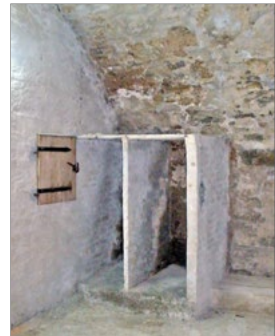
Aborte im Luftschutzraum
