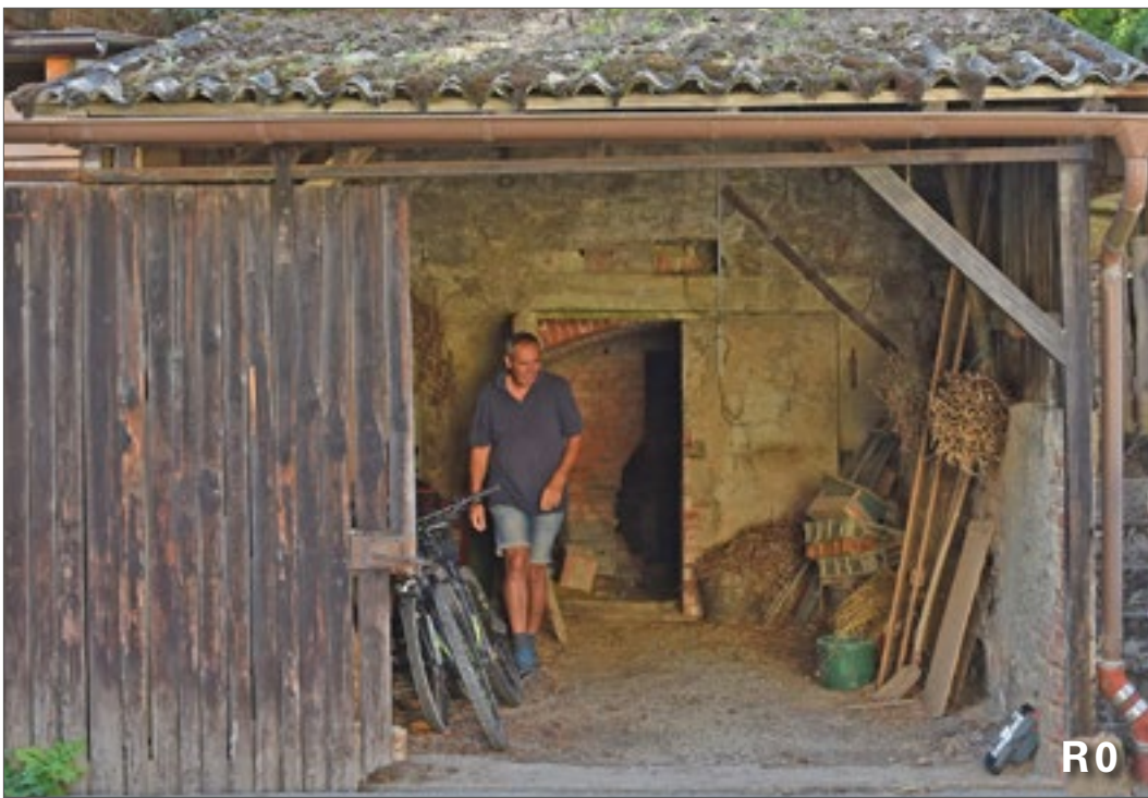
Schildmauer und Zugang des Eiskellers im vorgelagerten Schuppen (Raum 0) von Westen
