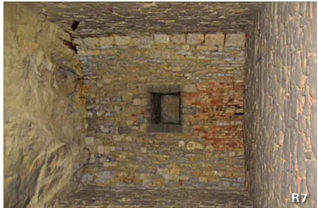
Schacht im Gewölbe des Eissilos (R7), ab 1944 mit Treppenhaus als Notausstieg versehen
