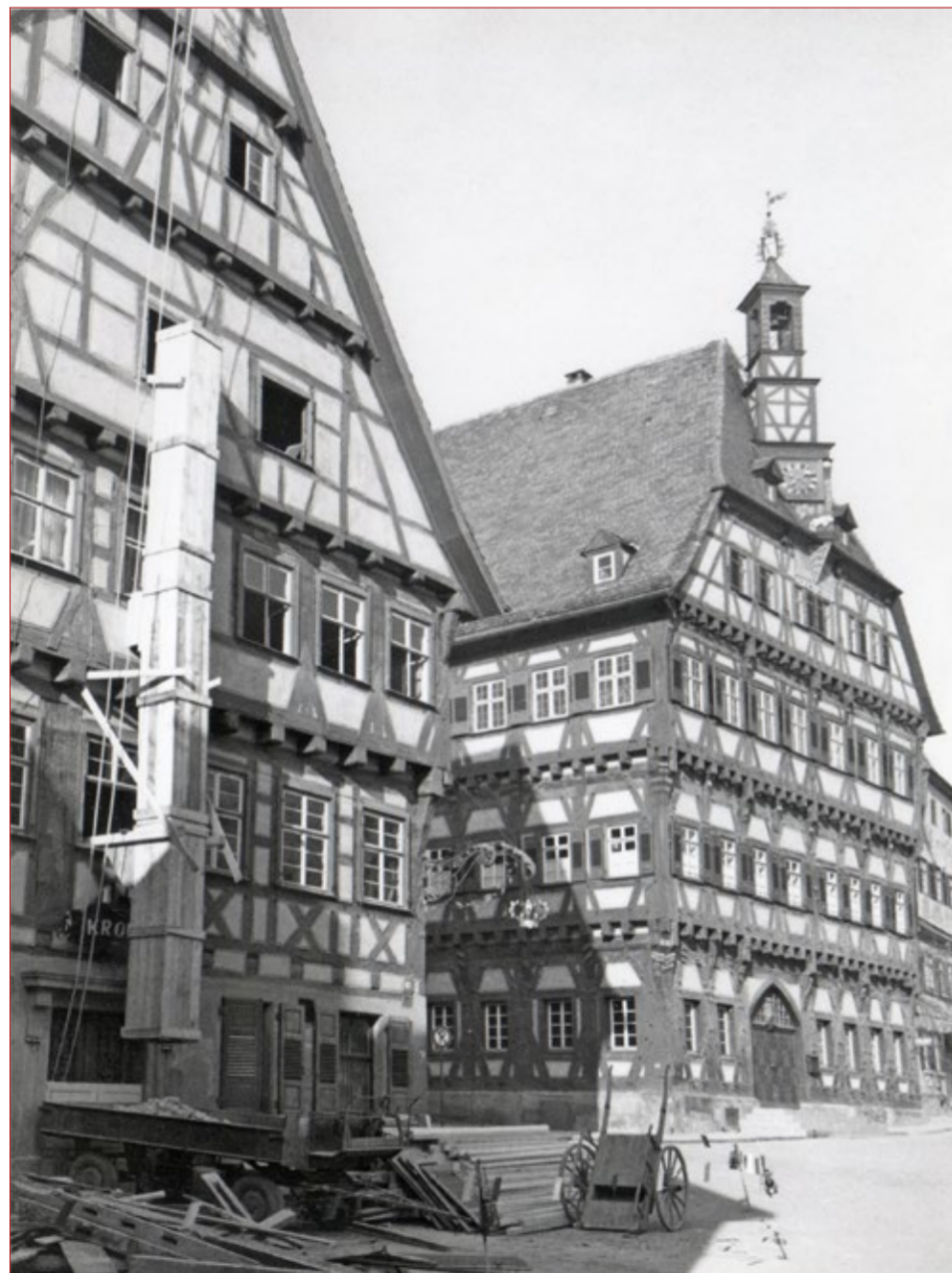
Dachgeschossausbau im April 1961 durch Architekt Eitel
