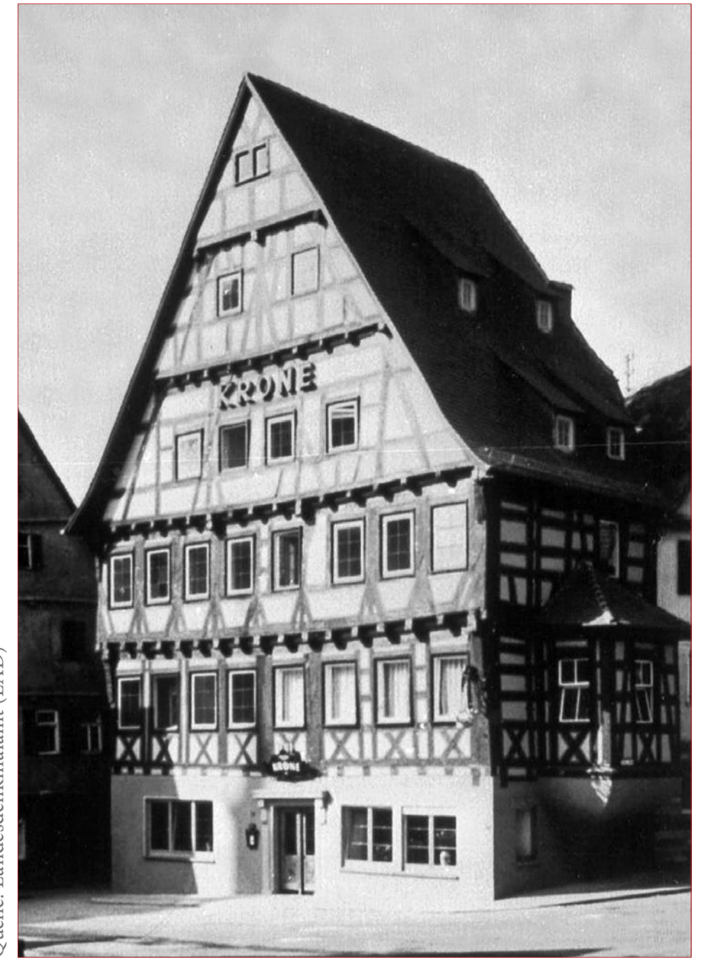
Nach dem Umbau 1964 ohne Kellerhals und mit Gaupen
